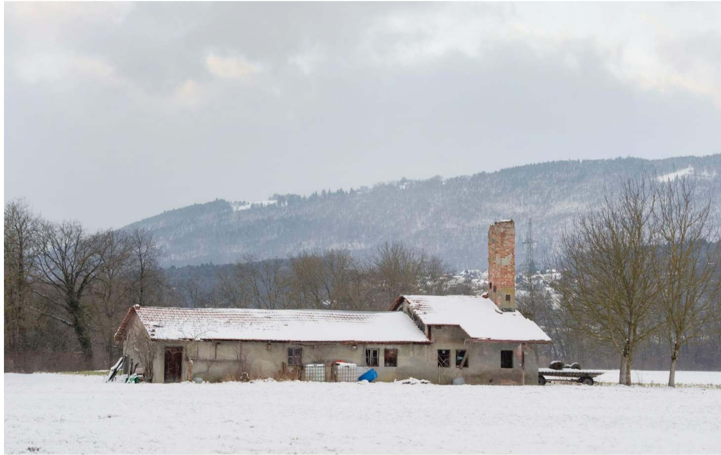
Die Wäscherei ist das einzige noch stehende Gebäude. Ursprünglich bestand das «Concentrationslager Büren» aus 120 Häusern. Bilder: Peter Samuel Jaggi
